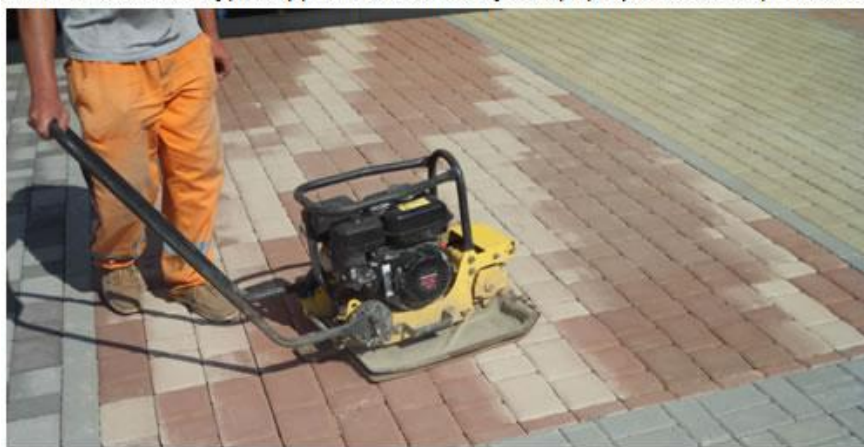
Zhutnenie dláždenej plochy pomocou vibračnej dosky s polyuretánovou podložkou
