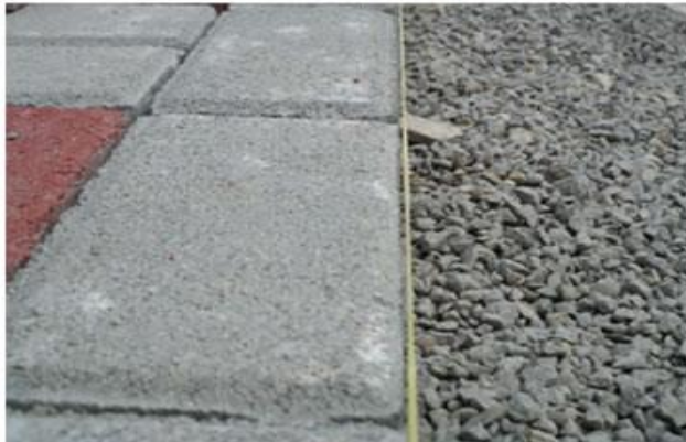
Rovná medzera sa dosiahne pomocou stavebnej šnúry
