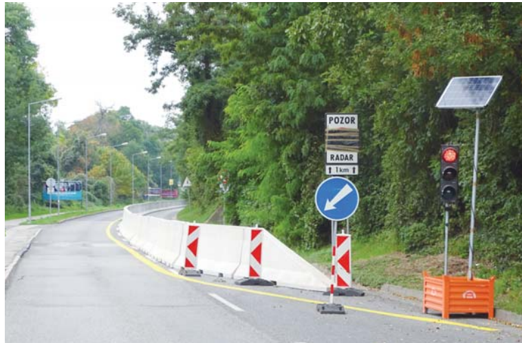
Doprava je zúžená do jedného jazdného pruhu a riadená svetelnou signalizáciou
