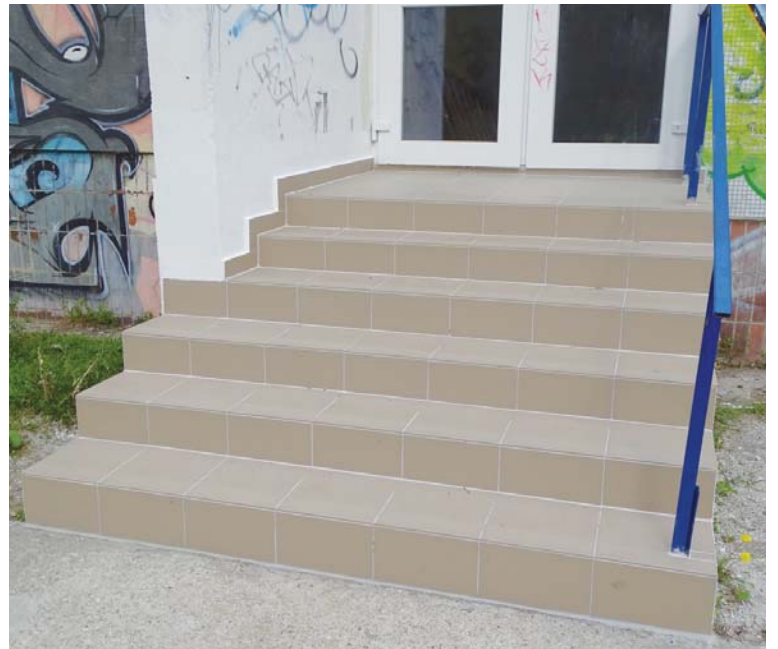
Opravené schody majú mrazuvzdorný a protišmykový povrch
